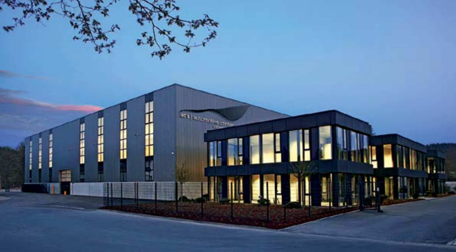
Neubau „Automotive Center Südwestfalen“
