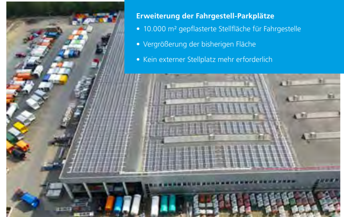
Photovoltaik-Anlage bei FAUN
