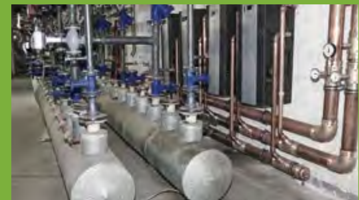
Frischwassermodule zur Trinkwassererwärmung im Durchlauferhitzerprinzip mit Kaskadenregelung.
